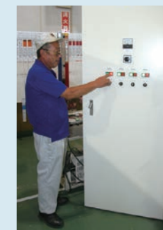
▲ 電気通電試験
